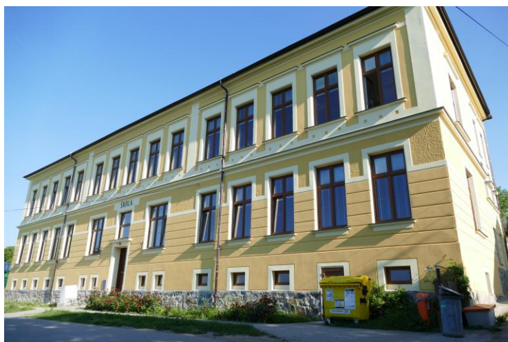
Budova školy v nové fasádě
